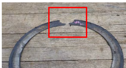
フランジ53：上部に欠損あり
