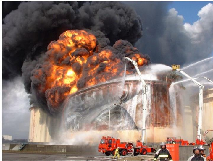
写真-1 浮き屋根式タンクの全面火災
