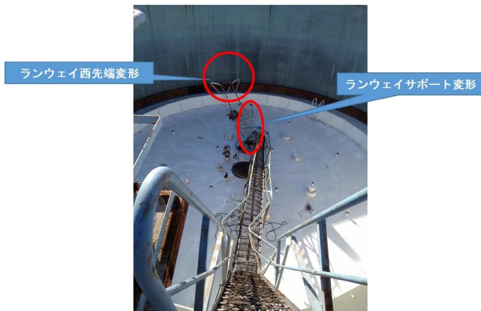
写真5 ランウェイサポート、ランウェイ西先端の変形状況
