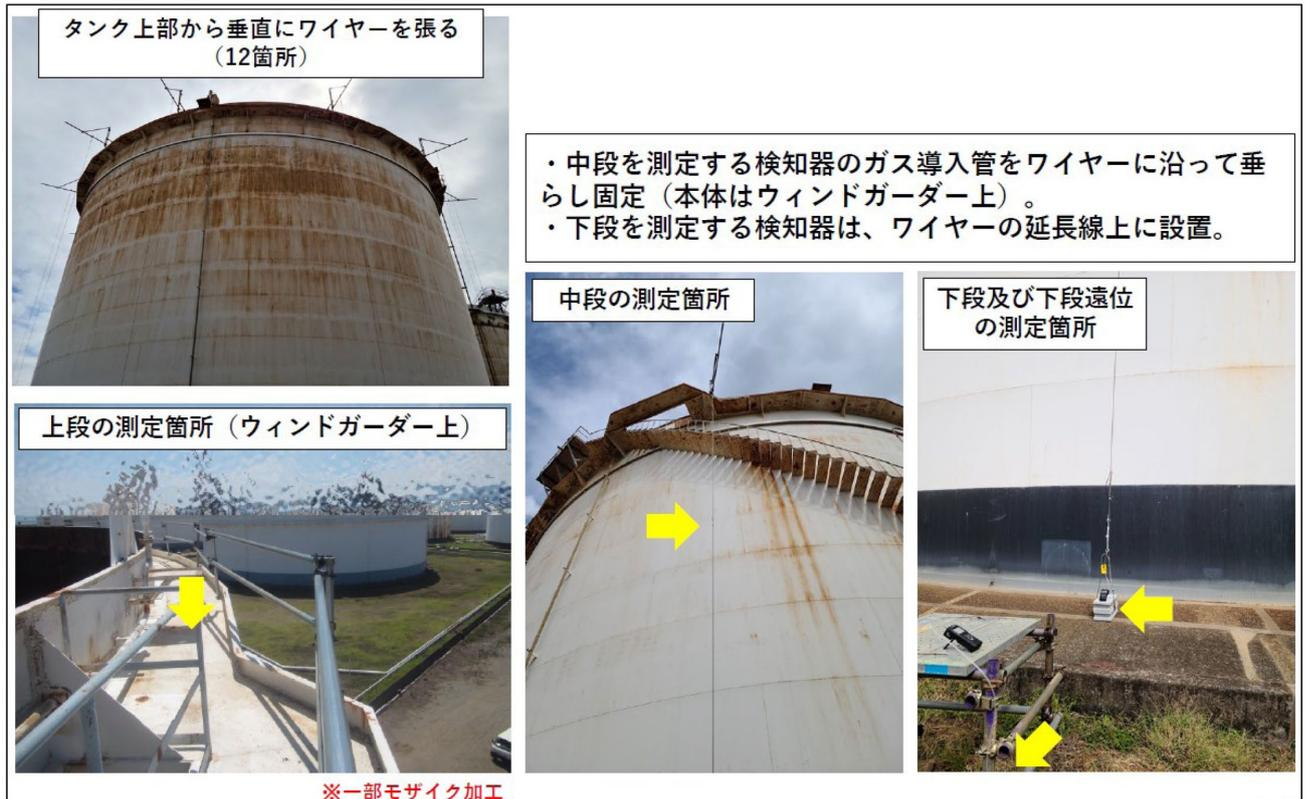
図2-5 ガス検知器設置状況 (浮き屋根を有する屋外貯蔵タンク)
