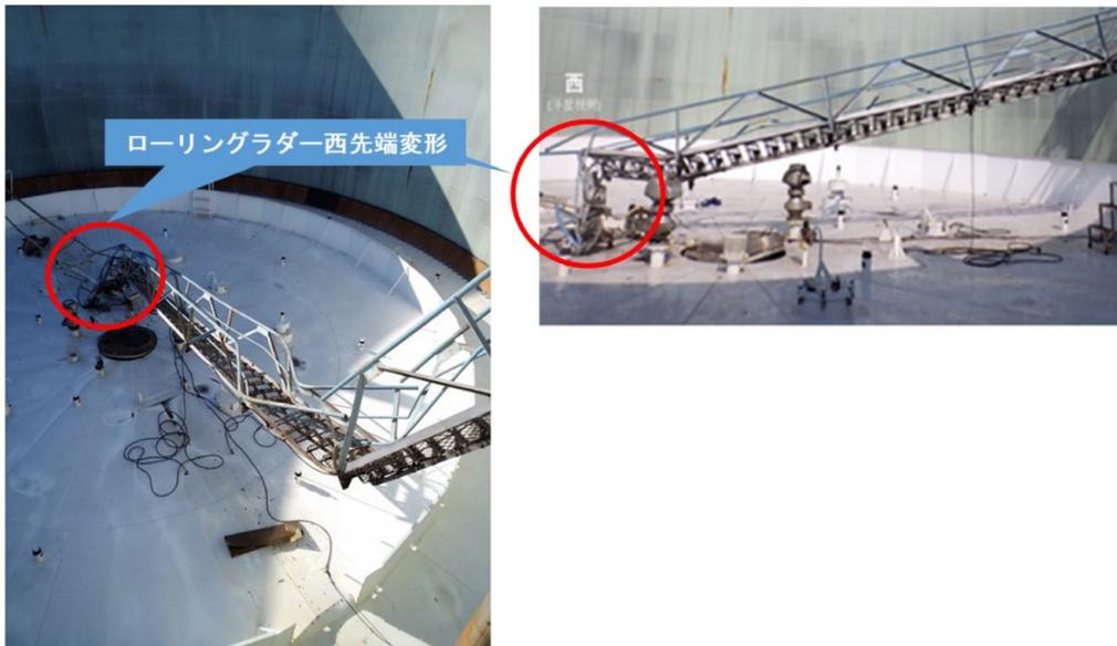
写真6 ローリングラダー西先端の変形状況
