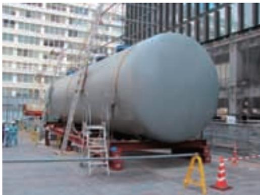
写真1 地下貯蔵タンク(地下タンク貯蔵所)
