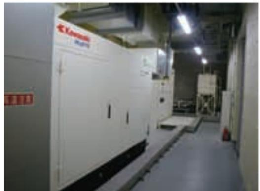
写真2 自家用発電設備(一般取扱所)
