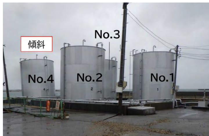
図15 石川県珠洲市内にあるB事業所の許可容量70kLのタンク(No.4)の被害(傾斜)。
