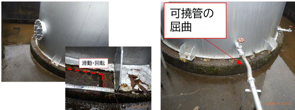
図14 石川県珠洲市内にあるA事業所の許可容量29.8kLのタンクの被害。
