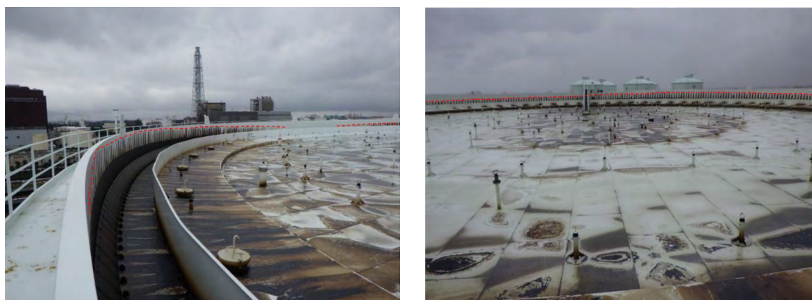
図8 新潟東港特防区域に立地する浮き屋根式原油タンクで発生したスロッシングによる油痕と浮き屋根上への滞油・油の飛散の状況。
