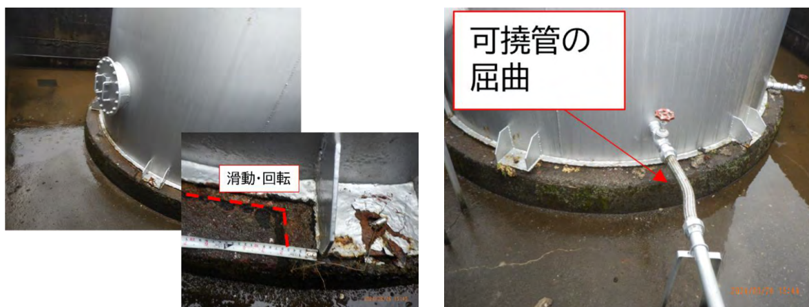
図14 石川県珠洲市内にあるA事業所の許可容量29.8kLのタンクの被害。
