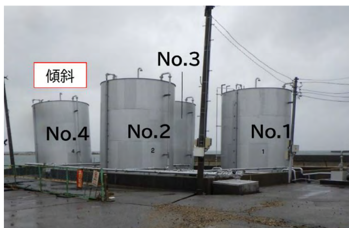
図15 石川県珠洲市内にあるB事業所の許可容量70kLのタンク(No.4)の被害(傾斜)。
