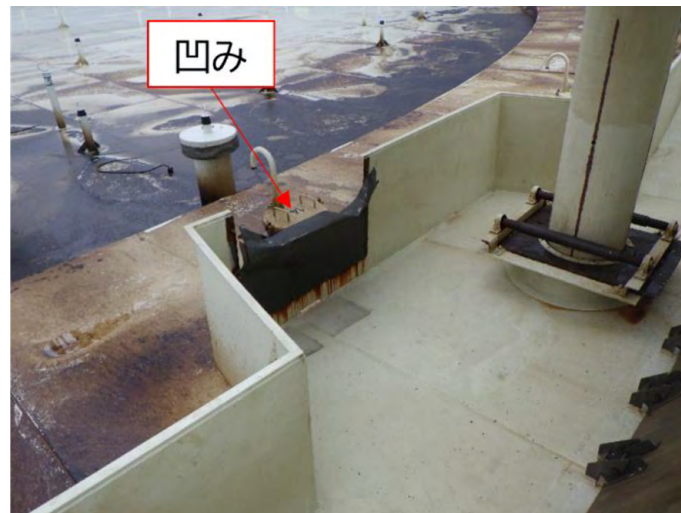
図10 ローリングラダーとフォームダムの一部（銅板部分）が 衝突することにより生じた銅板の凹み。
