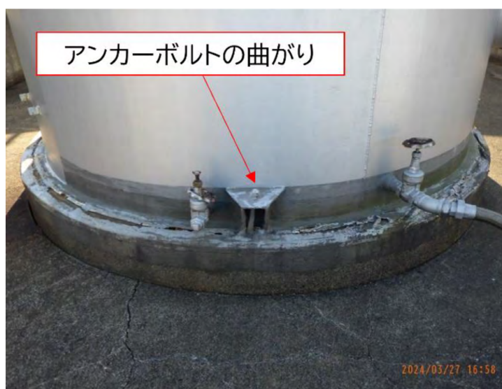
図16 石川県珠洲市内にあるC事業所の許可容量30kLのタンクの被害。
