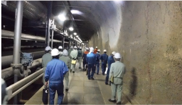
図19 サービストンネルの目視検査状況
