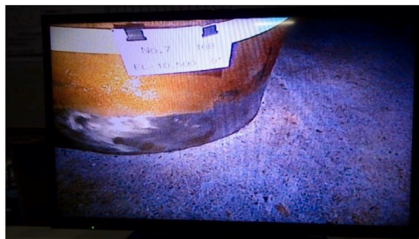
図29 配管等の豎坑プラグコンクリート貫通部
