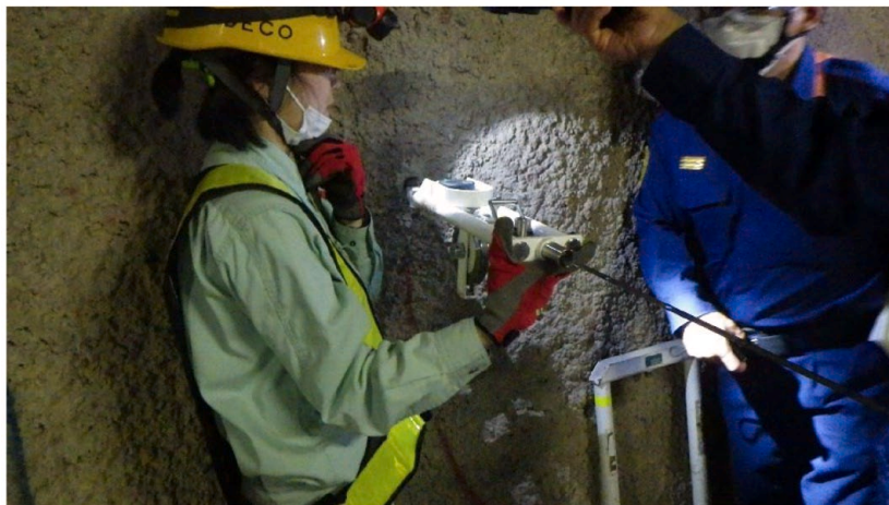
図14 内空相対変位測定状況
