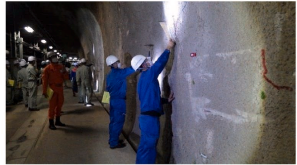
図20 サービストンネル壁面の打音確認
