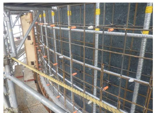
写真-2 PC 鋼材配置
