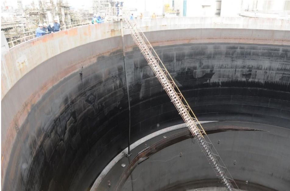
図2 平成23(2011)年東北地方太平洋沖地震の際の重油タンク浮き屋根沈没事故(川崎市)
