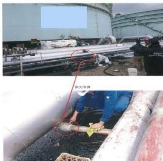
写真 4-4 危険物施設配管からの漏えい事例
