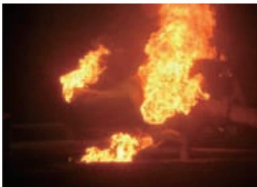
20:10頃 361タンク払出し配管(3ヶ所)の火災に対して水噴霧と粉末消火器(200型)により制圧を開始
