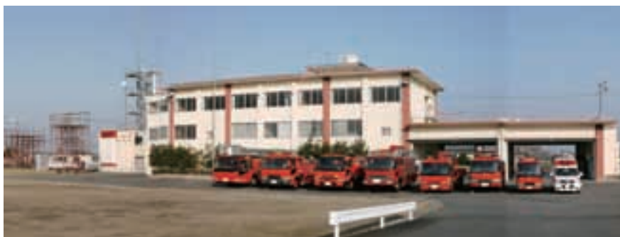
《消防本部庁舎》
