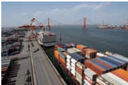
《 ふ頭に係留された大型コンテナ船 》
